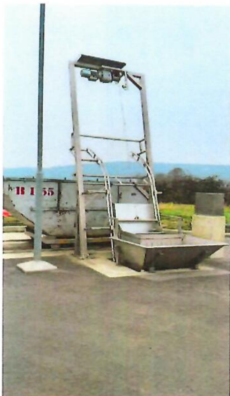
Naprava za sprejem »Odpadkov iz čiščenja kanalizacije« stoji na platoju ob komunalni čistilni napravi v Sečovljah
