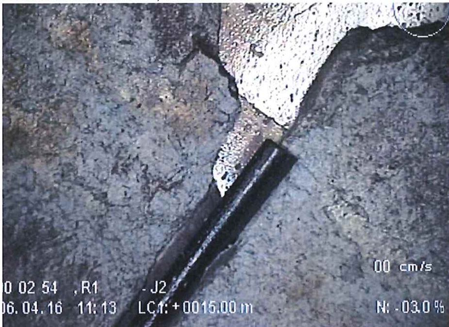
Poškodovana ležišča tesnil , obrušene stene
